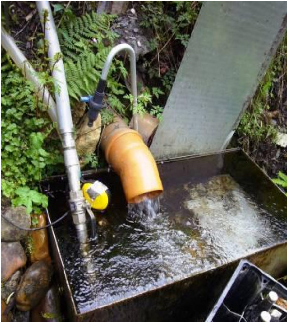
Abb. 30: Auslauf des Tiefen Stollens der Grube Mathilde (ZERBST, 2009)
