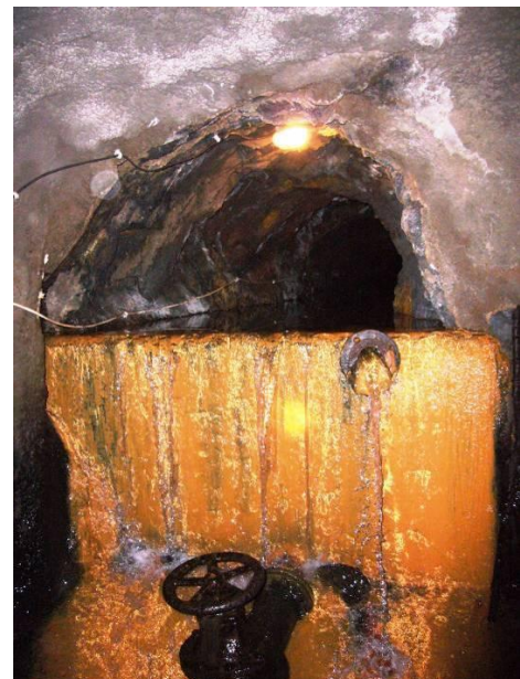
Abb. 15: Erster Querverbau (Hermann Erbstellen)
